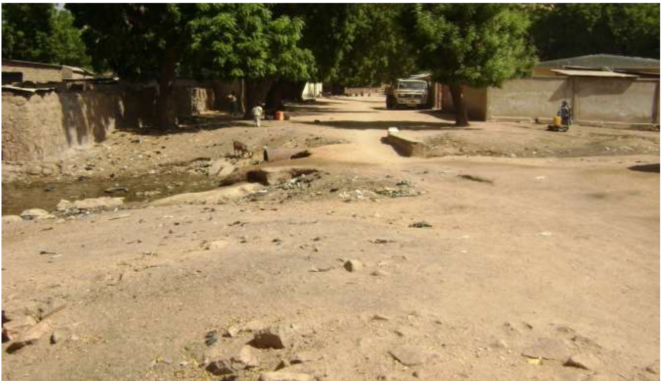
Photo 4 : Route et ouvrage d'art détruits par les eaux de ruissellement
